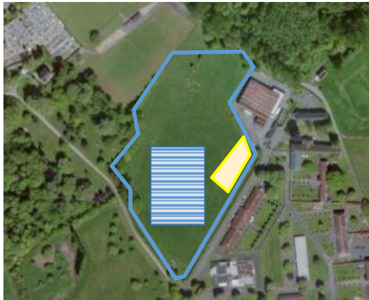
Figure 38 : Zone de stationnement des engins de chantier (géoportail).
